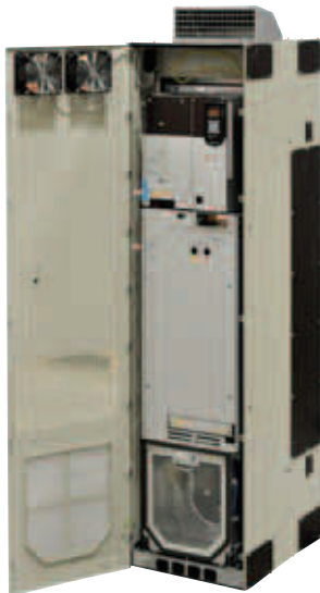
Преобразователь IP20, NEMA/UL тип 1 (шкаф типа 2500 СУЭД)
