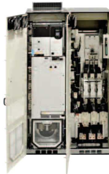
Преобразователь IP20, NEMA/UL тип 1, и доп. оборудование шкафа (шкаф типа 2500 СУЭД)
