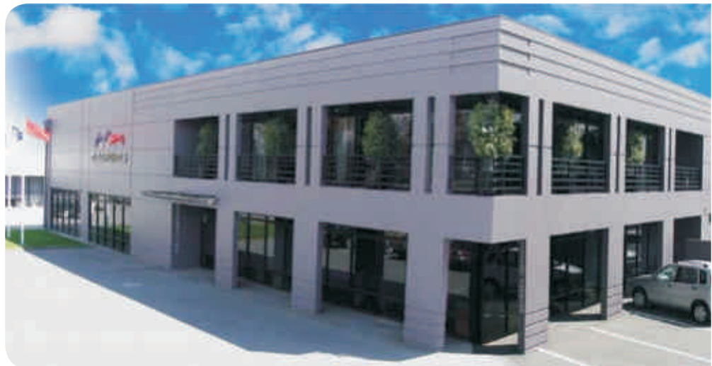
Завод Аисот в городе Крайстчерч (Новая Зеландия).
